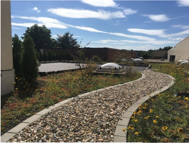
Begrünung der Dachfläche
